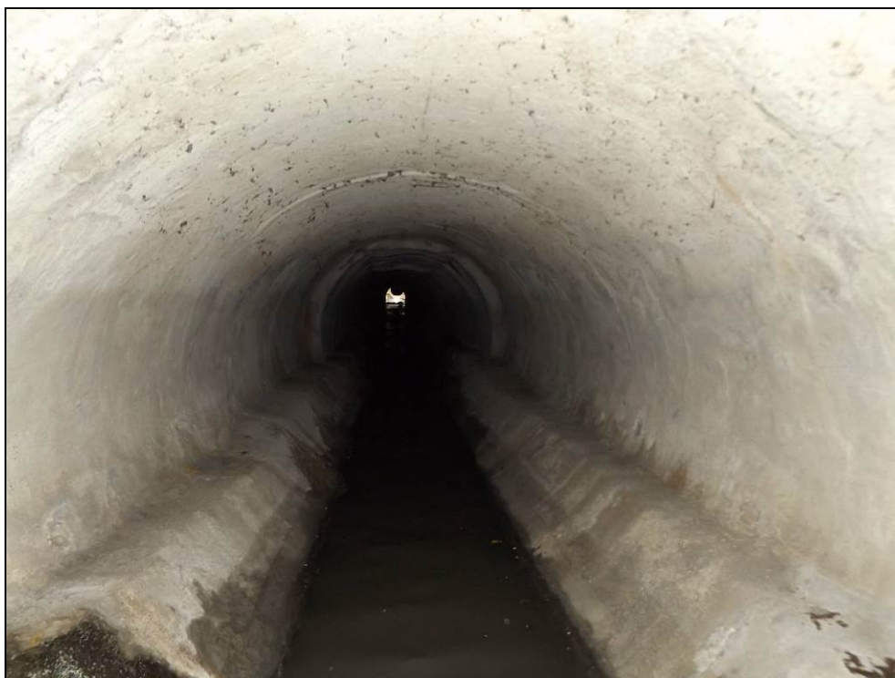
Obr. č. 9 - pohled do objektu zprava do hloubené části. Ostění je tvořeno prefabrikovanými ŽB rourami délek (dle spár v líci) cca 1800 mm
