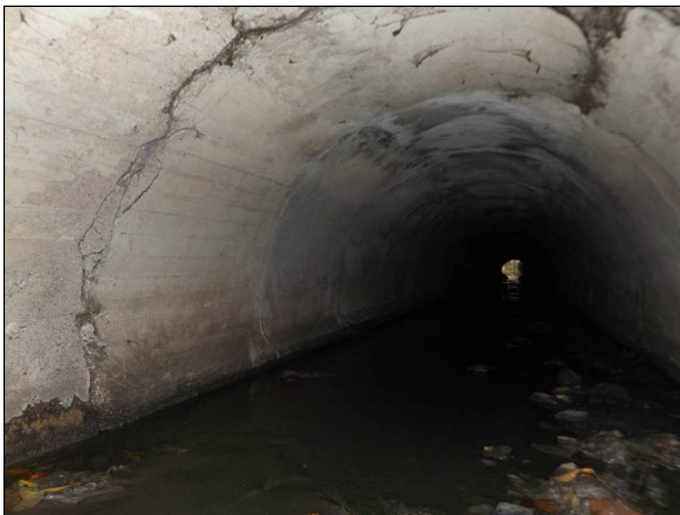
Obr. č. 6 - pohled do objektu zleva na pravděpodobně v místě rozhraní hloubené a ražené části, protože za tímto místem je ostění pravidelné se spárami po cca 1,0 m
