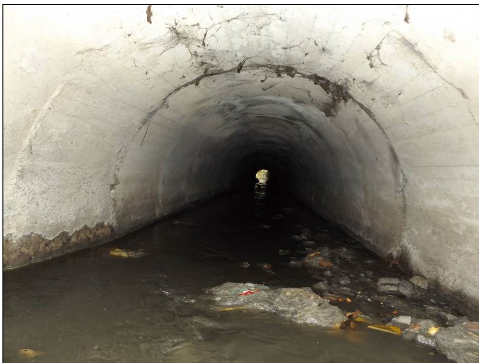
Obr. č. 7 - pohled do objektu zleva do ražené části pod kolejištěm. Zde je propustek zanesený min. na hloubku 0,5 m splaveninami. Skrze ostění dochází v místě spár k občasným průsakům
