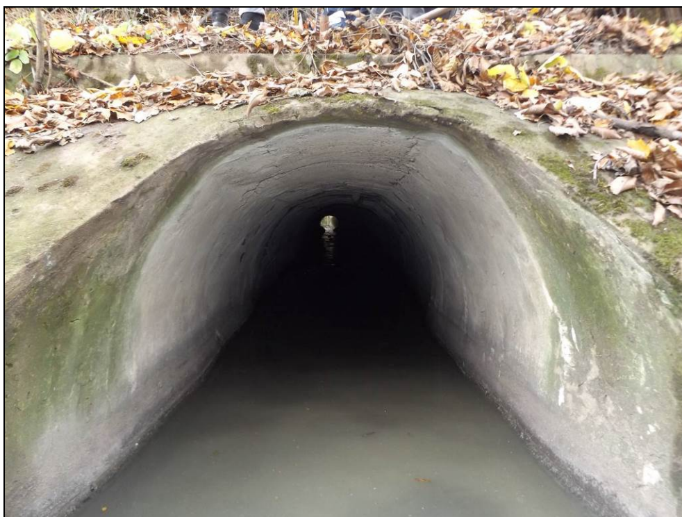
Obr. č. 4 - pohled na levé čelo na vtoku. Od čela měl být objekt prováděn na délku min. 2,5 m jako hloubený.
