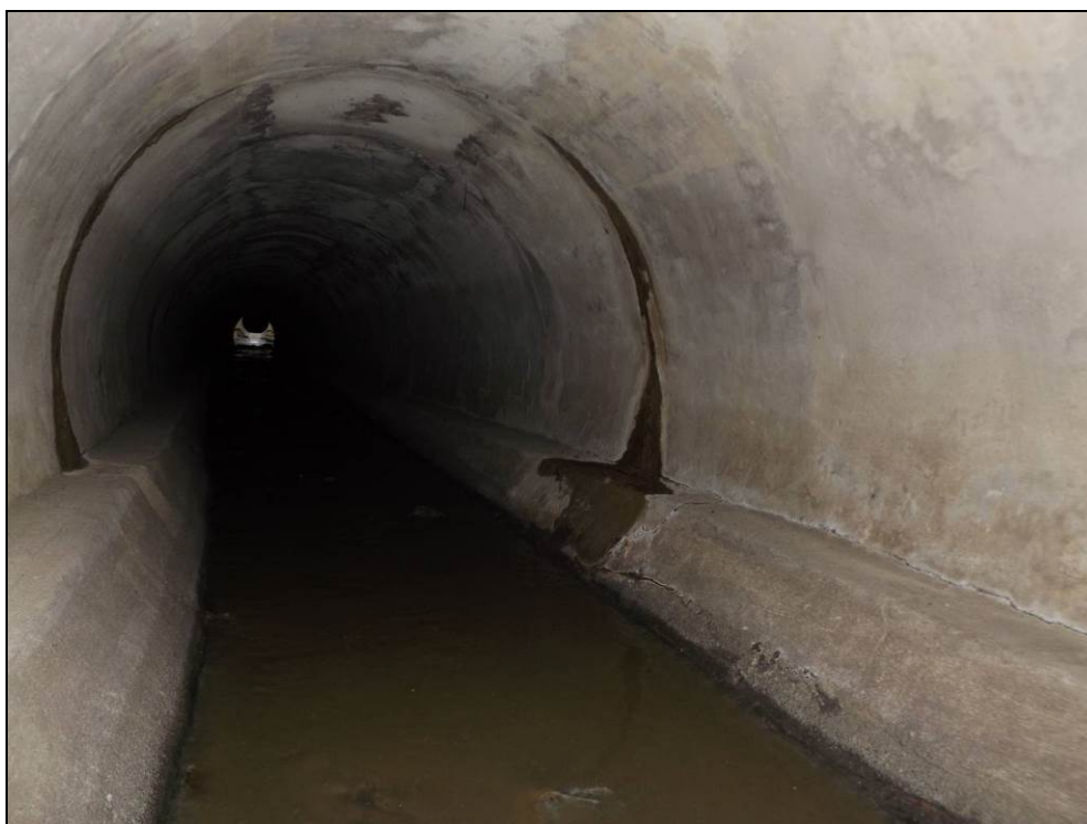
Obr. č. 12 - pohled do objektu zprava, ražená část. Místy dochází k soustředěným průsakům skrze spáry v ostění.
