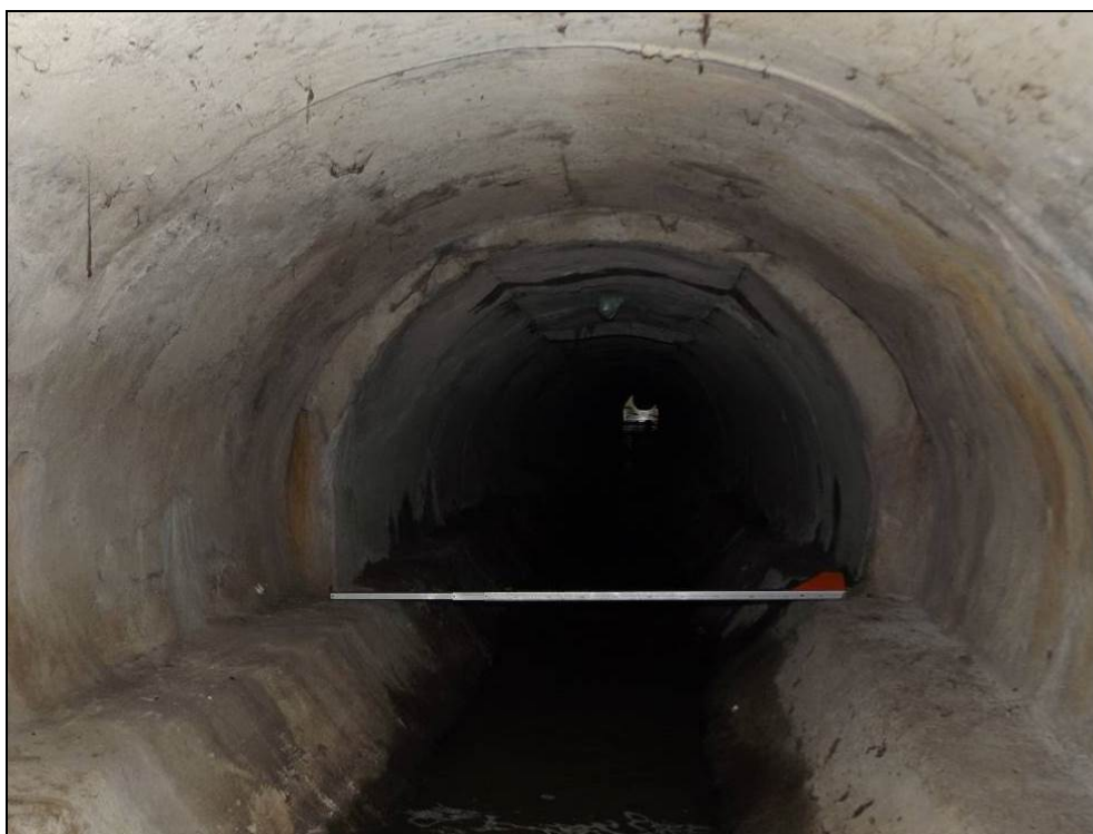
Obr. č. 10 - pohled do objektu zprava, pravděpodobně rozhraní mezi hloubenou a raženou částí. Dochází zde k zúžení vnitřního profilu a změně typu ostění.
