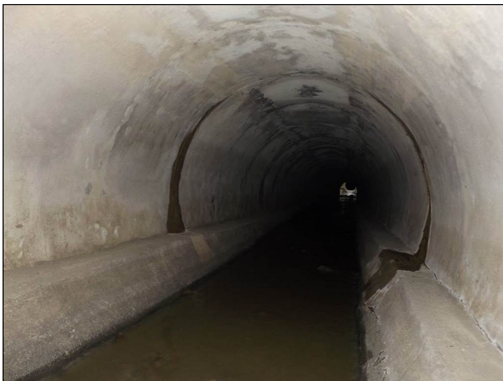
Obr. č. 11 - pohled do objektu zprava, ražená část. Ostění je z prostého monolitického betonu (dle stop po bednění líce).
