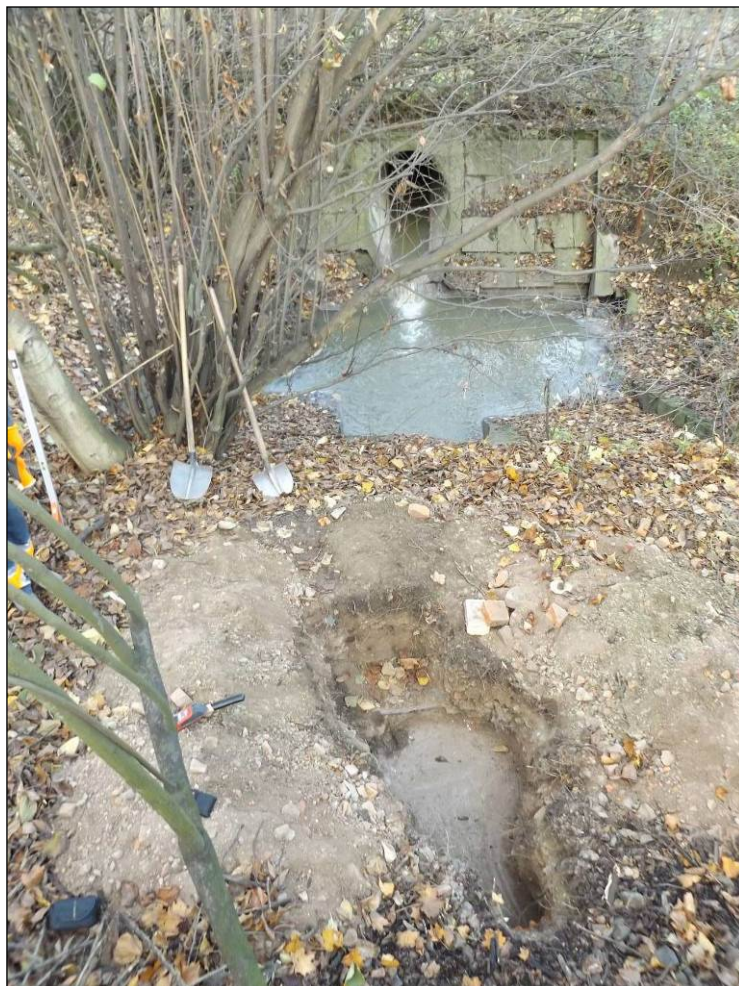
Obr. č. 13 - levé čelo objektu, pohled shora od kolejiště na kopanou sondu nad levým čelem. Vzadu je výtok z kanalizace do jímky na vtoku. Kopaná sonda byla původně určena k obnažení primárního ostění.
